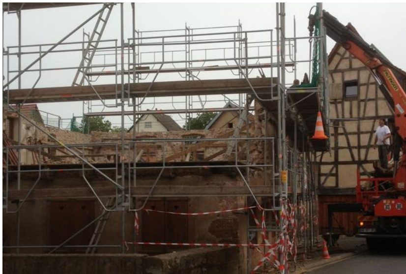
Le démontage de la maison cet été a fait croire à certains habitants de Weinbourg à une démolition. DOCUMENT REMIS
