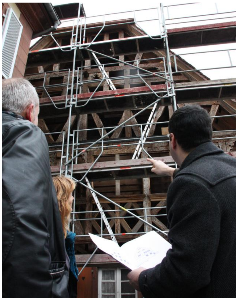
Les travaux extérieurs de la maison médiévale située en plein centre de Weinbourg devraient être achevés l'été prochain. PHOTOS DNA - G.B.
