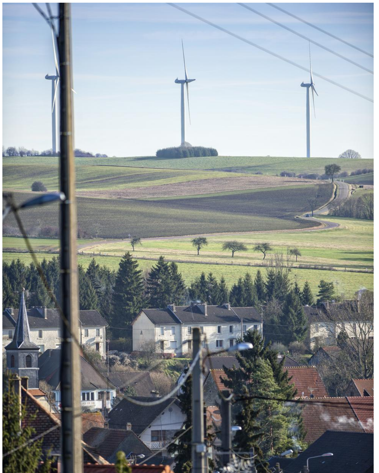
Le parc des éoliennes de Dehlingen reste l'exemple le plus visible des actions de transition énergétique sur le territoire nord-ouest de l'Alsace. PHOTOS ARCHIVES DNA – MARC ROLLMANN
