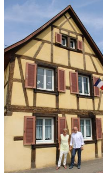
A Zillisheim (Haut-Rhin) : cette maison de la fin du XVIII e siècle a bénéficié d'une rénovation de niveau BBC.
