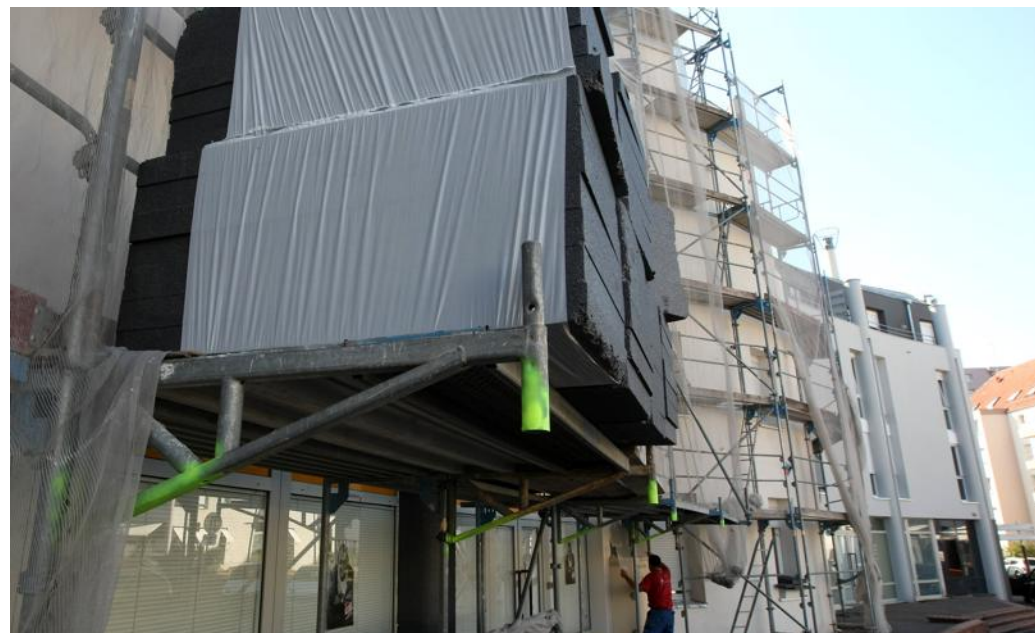
A Ostwald, rue René-Cassin, le bailleur social Domial réalise actuellement la rénovation énergétique d'une résidence de 38 logements. PHOTO DNA - LAURENT RÉA
