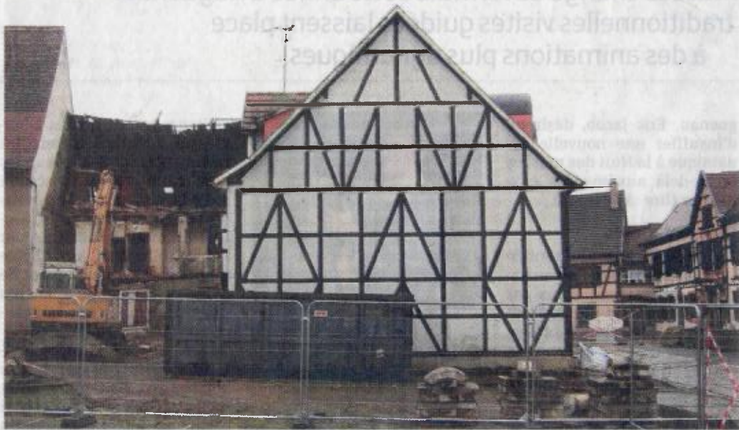
La démolition de la maison Siffert (à gauche) est actuellement en cours. PHOTOS DNA - E. S.
