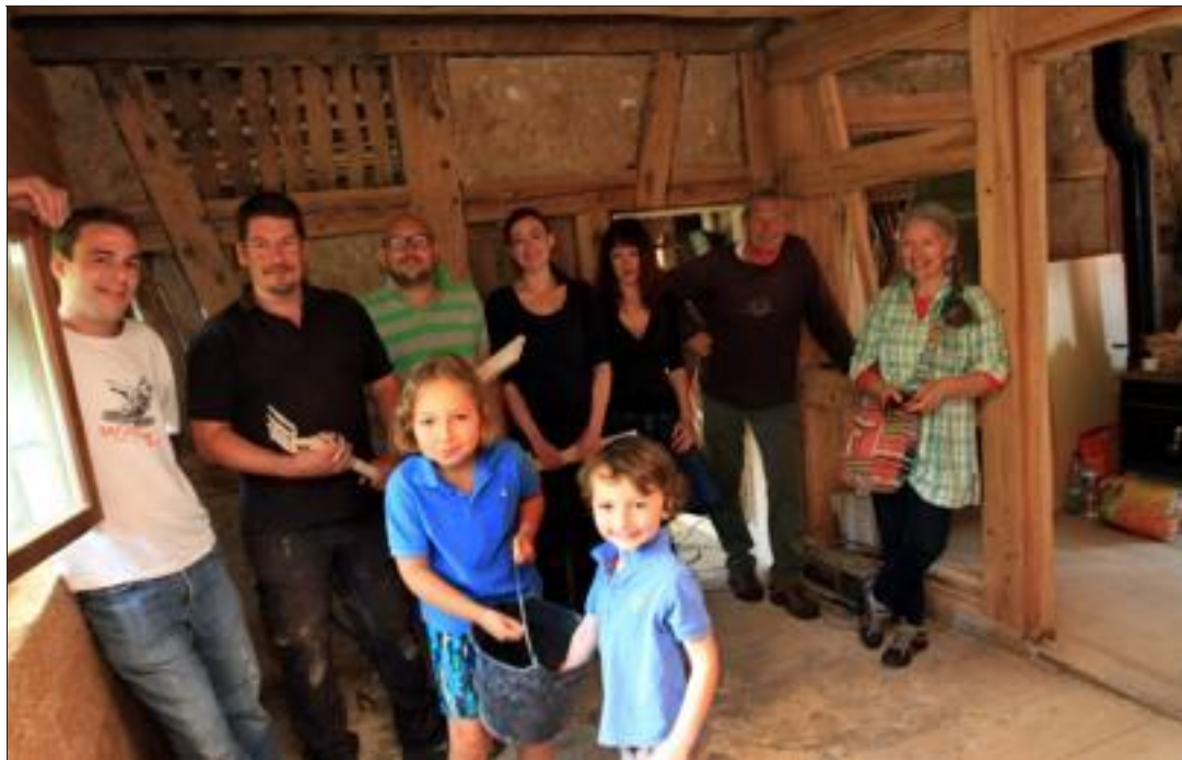
Samedi à Zimmerbach, des membres de l'Asma ont visité un chantier de restauration d'une maison du XVIII e siècle dont l'isolation est réalisée en chanvre et chaux. Photo Jean-François Frey
