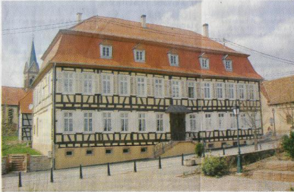
La récente rénovation du presbytère de Kutzenhausen (construit en 1723) a été primée par l'Asma le 2 avril. (Photo DNA)
