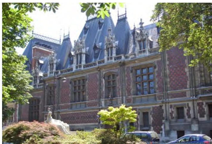
© Milena Chessa / Le Moniteur.fr - Bâtiment inscrit (hôtel Gaillard, Paris 17 e , propriété de la Banque de France)
