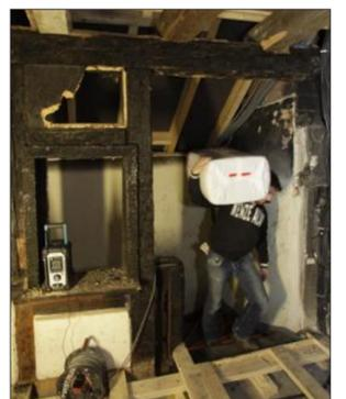
À l'étage du numéro 56, les vieilles poutres pas trop calcinées sont grattées pour être conservées. Photo L'Alsace/Hervé Kielwasser
